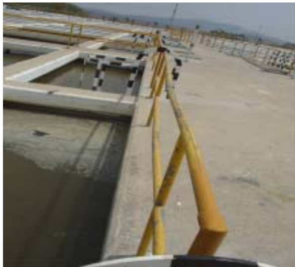
Cambio escaleras en Planta Convencional
