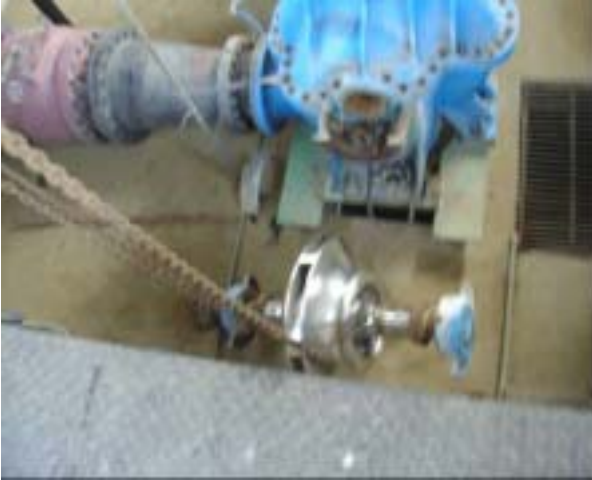
Reparación bomba EB N° 2
