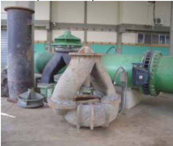
Cuerpos de bombas en reparación EB N° 4
