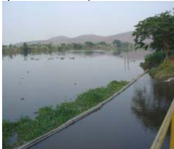
Vista del arrastre de camalotes en el ingreso a Criba N° 1
