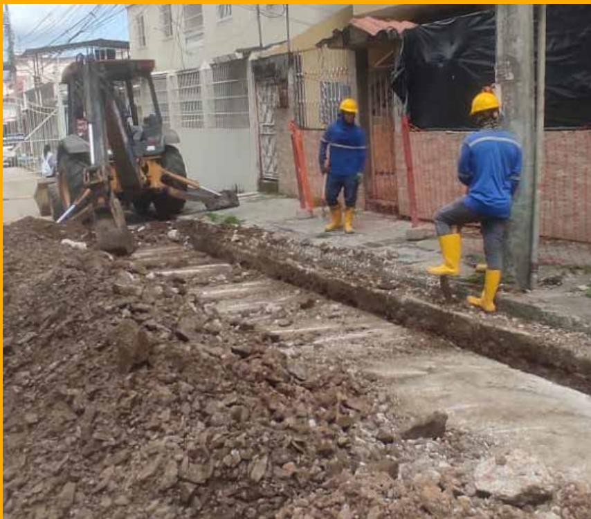
ramaless secundarios de 175 mm que cubrirán otros 130 metros. Las obras incluyen también la construcción de cámaras de inspección y cajas domiciliarias para garantizar un sistema de evacuación de aguas residuales más eficiente.
